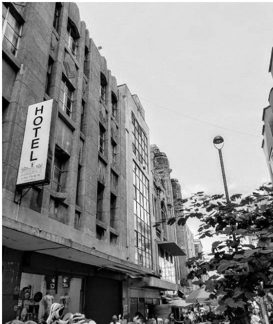
Estado actual del edificio del Banco Grancolombiano
